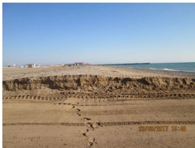
Р и с . 8 . Планирование рельефа пляжа полного профиля на пересыпи оз. Сасык-Сиваш
