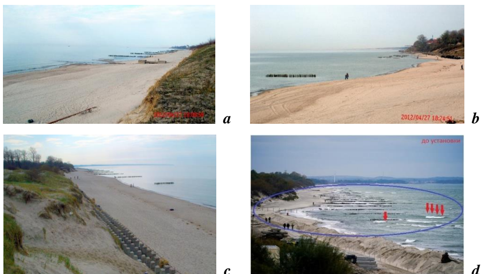
Р и с . 2 . Состояние пляжа: a – стабильный пляж на западной оконечности участка старых бун начала XX в., 27 апреля 2012 г.; b – низовой размыв на восточной оконечности участка старых бун начала XX в., 27 апреля 2012 г.; c – сезонное восстановление пляжа, заметное по полосе намытого песка, в том числе и в теневой зоне бун, 27 апреля 2012 г. (фото – А. Н. Бабаков); d – состояние до начала периода осенне-зимних штормов 2020 г., 19 октября 2020 г. Стрелками указано будущее положение модулей волнолома
