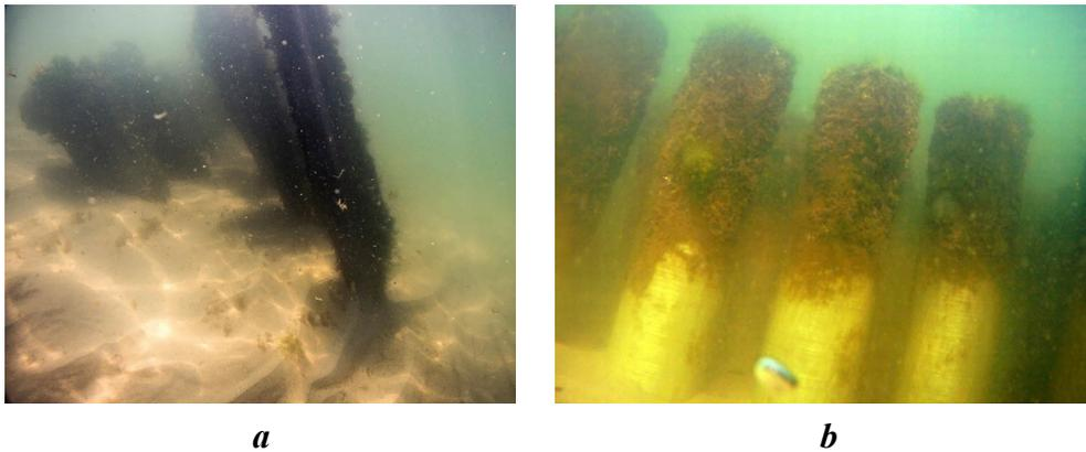
Рис. 4. Состояние модулей волнолома «Гребенка»: *a* – обрастание водорослями до дна и наклон конструкции (съемка 07.09.2022); *b* – послештормовое обнажение от песка части волногасящих свай (съемка 12.04.2023 г.)
