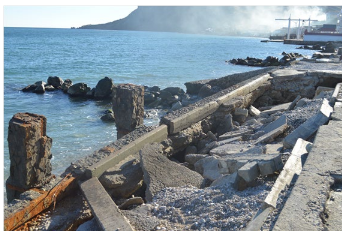
Р и с . 8 . Участок резервной отсыпки. Фото 2021 г.
