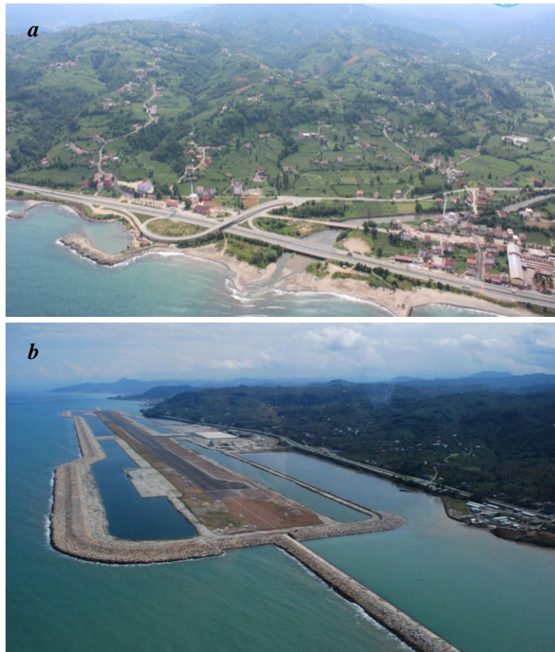
Рис. 10. Причерноморская магистраль в районе западнее г. Ризе ( a ), аэропорт между г. Орду и г. Гиресун ( b )
