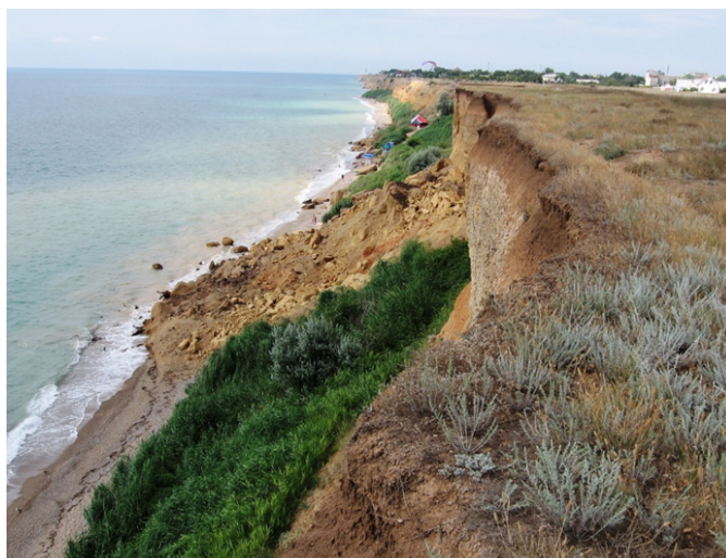
Рис. 3. Последствия обвала в июле 2010 г.
