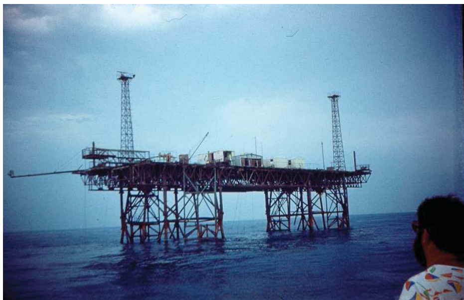
Р и с . 1 . Свайное основание на шельфе Каспийского моря, с которого проводились измерения внутренних волн пространственной антенной распределенных датчиков температуры в 1977 – 1978 гг. Снимок сделан с отходящего от платформы судна. В правом нижнем углу снимка В.А.Иванов бросает прощальный взгляд на платформу. Он закончил исследования на каспийском шельфе и ему предстоял переезд в Крым, связанный с новым этапом научной карьеры – переходить на исследования в Черном море.
