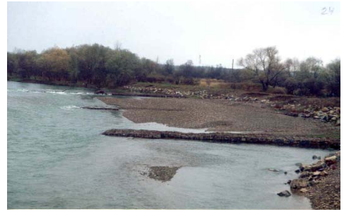
Р и с . 6 . Компьютерный расчет деформации речного ложа возле полузапруды (а); система низких затопляемых полузапруд на вогнутом берегу карпатской реки для борьбы со свальными течениями и размывами. Видно занесение межполузапрудных пространств гравийными отложениями (б).
