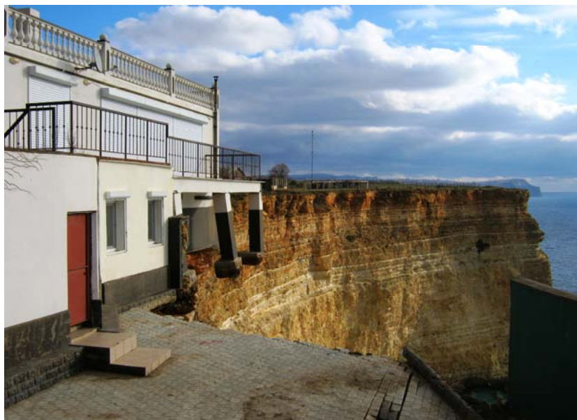
Рис. 4. Повреждение дачи (садовое товарищество «Муссон») в результате обвала в 2013 г.
