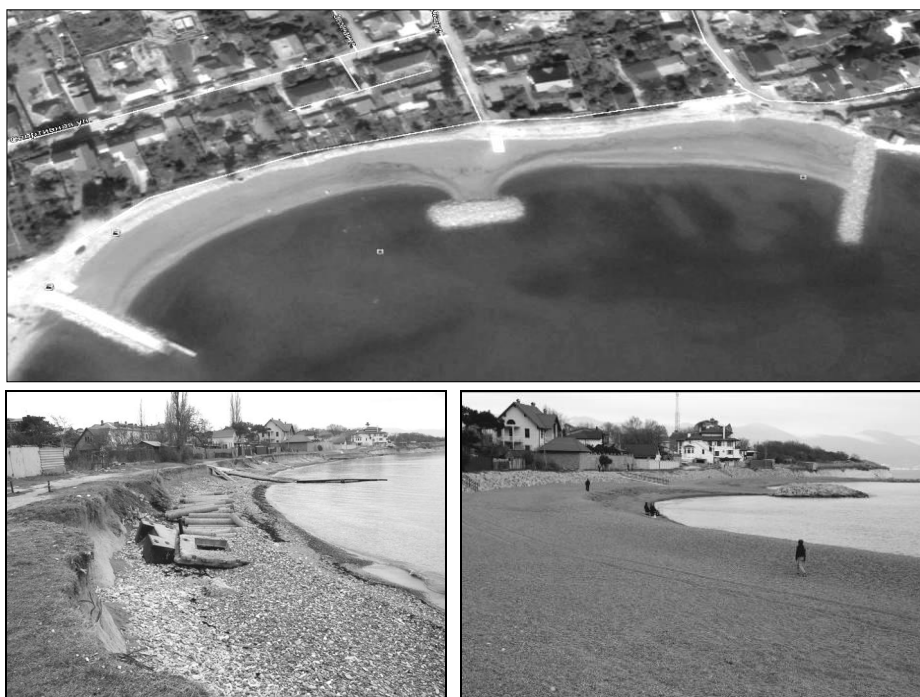
Р и с . 4 . Искусственный пляж в Мысхако (380 м) под защитой двух бун и волнолома из природного камня в 2013 г. (внизу слева); 2014 г. (внизу справа).
