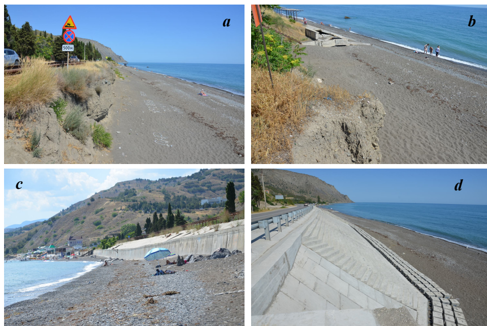
Рис. 4. Берег в районе участка исследования у п. Морское (03.07.2019 г.): a – общий вид с запада; b – восточная часть; c – участок берега, примыкающий с запада к исследуемому участку; d – новые берегозащитные сооружения к востоку
